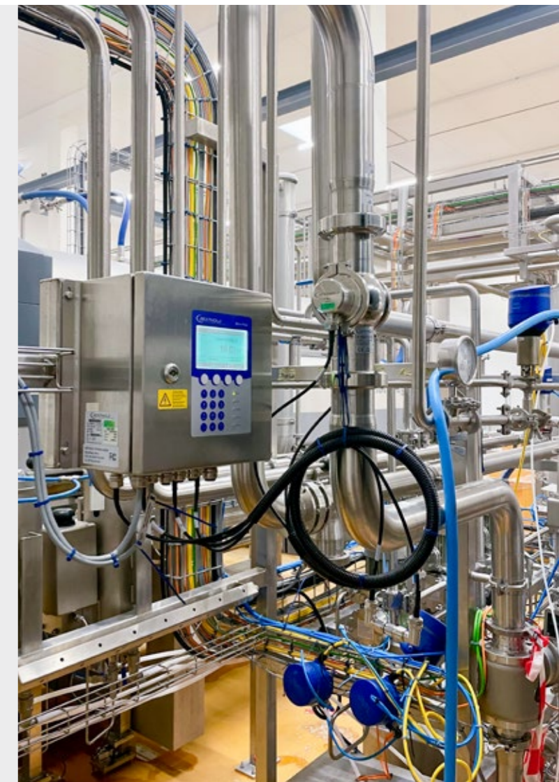
Schematische Darstellung einer Wasser-/Trockengehaltsmessung an einer Rohrleitung mit FlowCell
