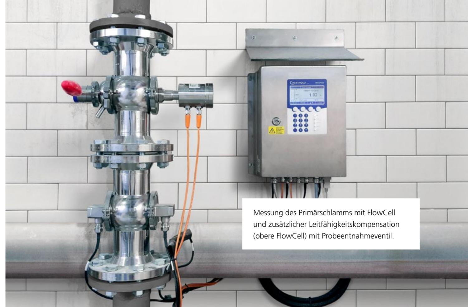
Messung des Primärschlammes mit FlowCell und zusätzlicher Leitfähigkeitskompensation (obere FlowCell) mit Probeentnahmeventil.
