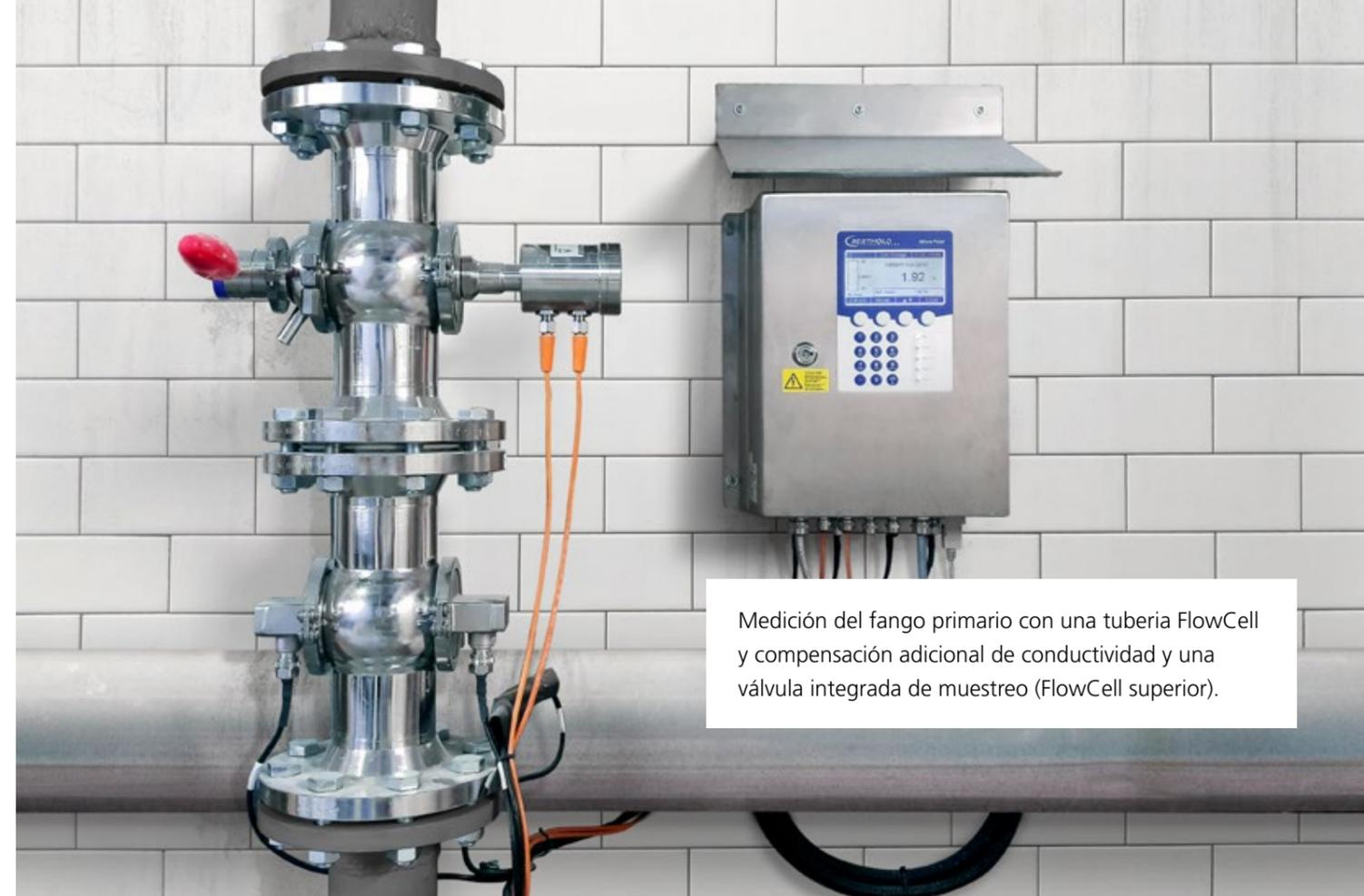
Medición del fango primario con una tubería FlowCell y compensación adicional de conductividad y una válvula integrada de muestreo (FlowCell superior).
