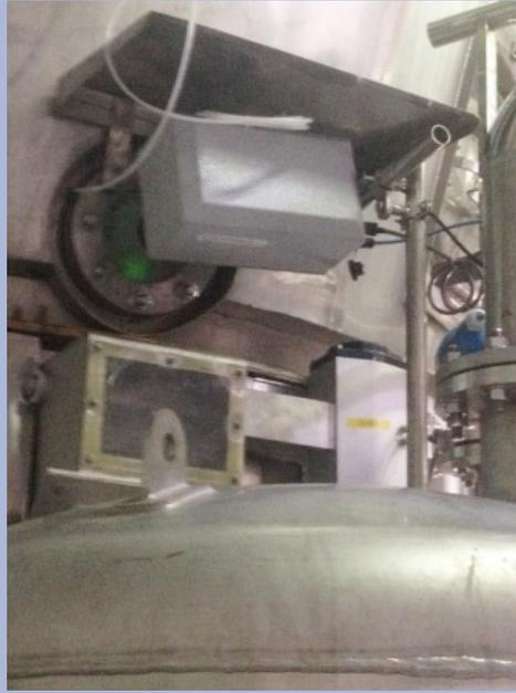
*Implantation sur hublot en partie basse du sécheur*
